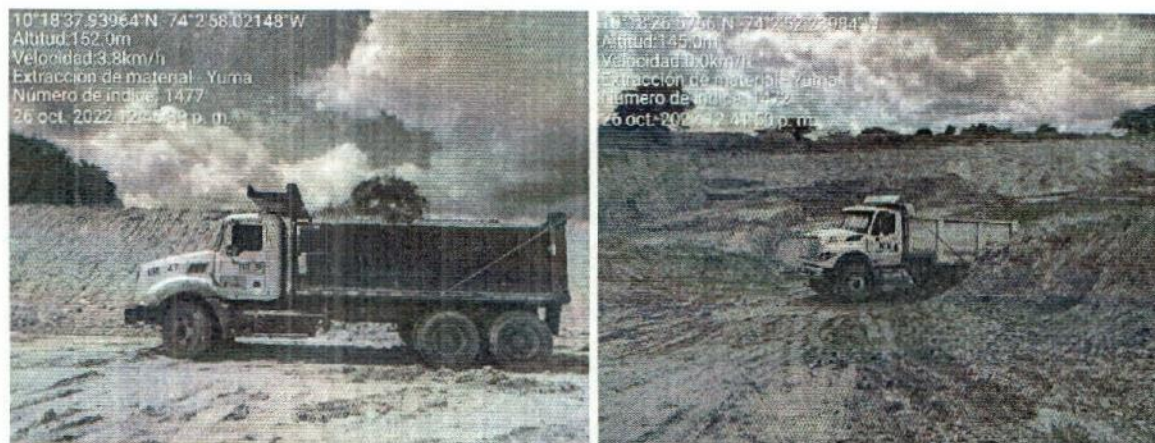
Imagen 2. Volquetas con cargue de material
