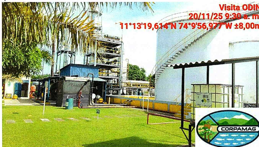
Foto 01. Tanques de Almacenamiento y Unidad de Proceso durante la Visita de Inspección de CORPAMAG (20/11/2025)
