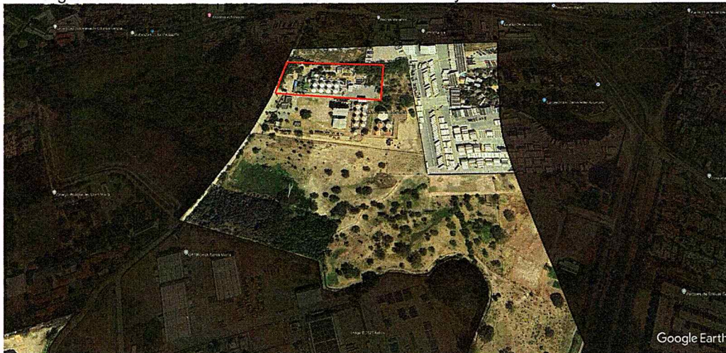
Figura No. 02. Acercamiento de la localización del Proyecto Odin Petroil en el entorno
