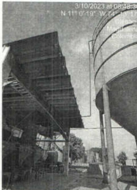
**Fotografía 2:** Ausencia de banda transportadora entre tolvas de alimentación y el silo de carbón.
