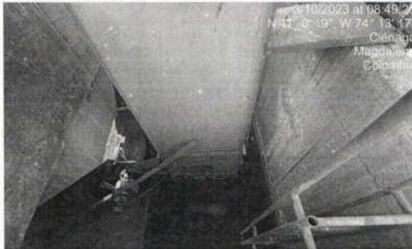
Fotografía 4: Silo de carbón sin motores de conducción, el interior se evidencia sin mantenimiento, ni operación.
